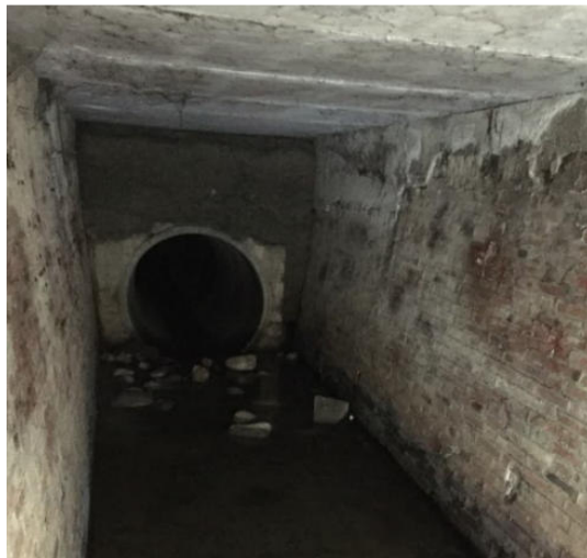
Tubazione di scarico dello scaricatore verso il Fiume Secchia
