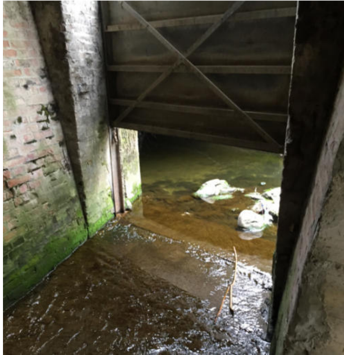
Scarico di fondo dello scaricatore – paratoia in posizione di apertura durante il periodo non irriguo
