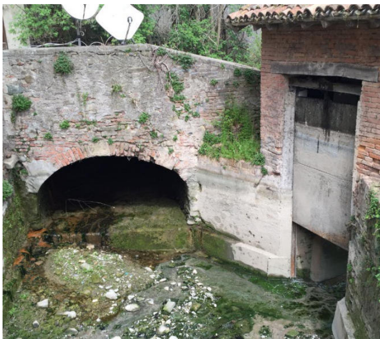
Canale di Secchia sulla sinistra e scaricatore Rio Rocca sulla destra (paratoia scarico di fondo in posizione di apertura durante il periodo non irriguo)
