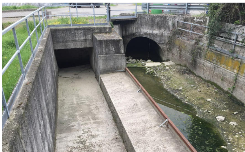
Vista da valle dello scaricatore Monte Arnone – sfioratore laterale
